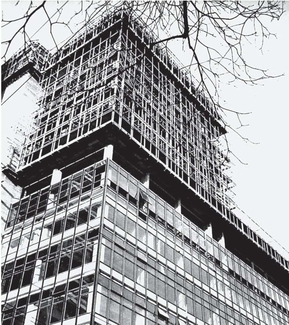
Edifício Cásper Líbero em construção, na década de 1960
