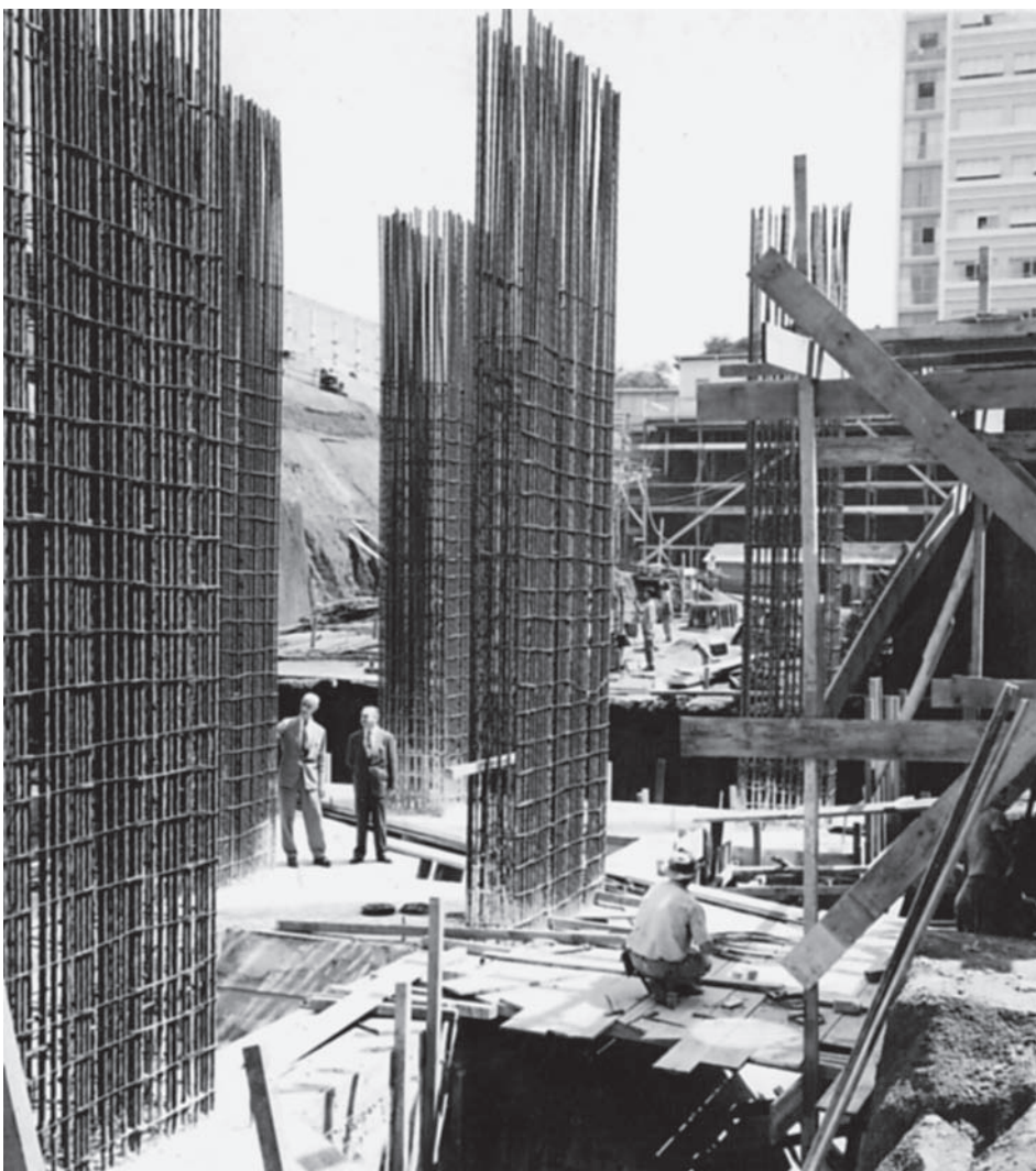
Carlos Joel Neli (esq.) mostra a visitante o tamanho das vigas
